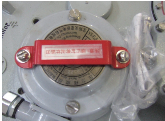
图 25 压力释放阀保护
